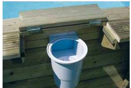
Margelle articulée pour faciliter l'accès au Skimmer
